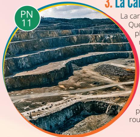
La carrière de porphyre de Quenast est l'une des plus grandes d'Europe. Ancien magma refroidi, le porphyre extrait était utilisé pour les pavés des routes. Aujourd'hui, le concassé de porphyre est un ingrédient d'application pour le béton et les routes.
